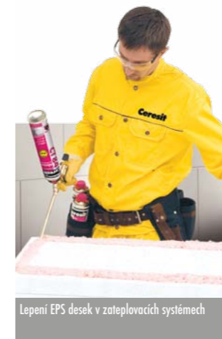
Vyplnění spár při sesazení desek izolantu
