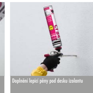
Lepení na již zateplený podklad
